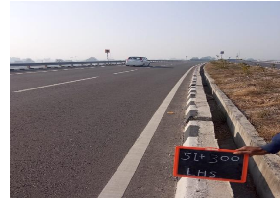
Fig 4.212: MBCB Ch 51+300 LHS
